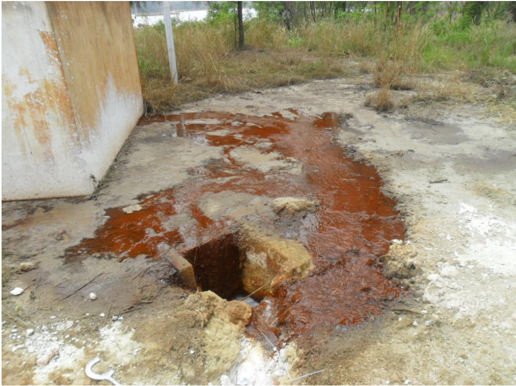
ภาพที่ ค-5 สารเคมีหกรั่วไหลจากภาชนะจัดเก็บลงสู่พื้นดินโดยตรงและ ลงสู่ท่อระบายน้ำฝนโดยไม่มีการจัดการใดๆ
