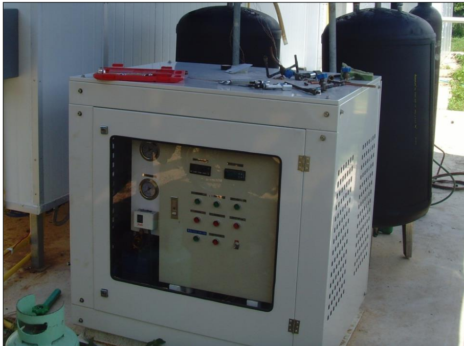
รูปที่ 3.1 ระบบปั๊มความร้อนแบบอัดไอ
